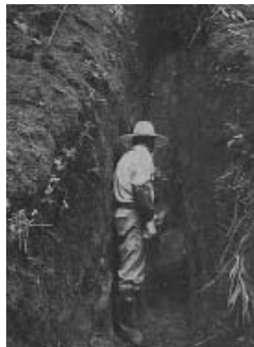
トレンチによる鉱床調査
